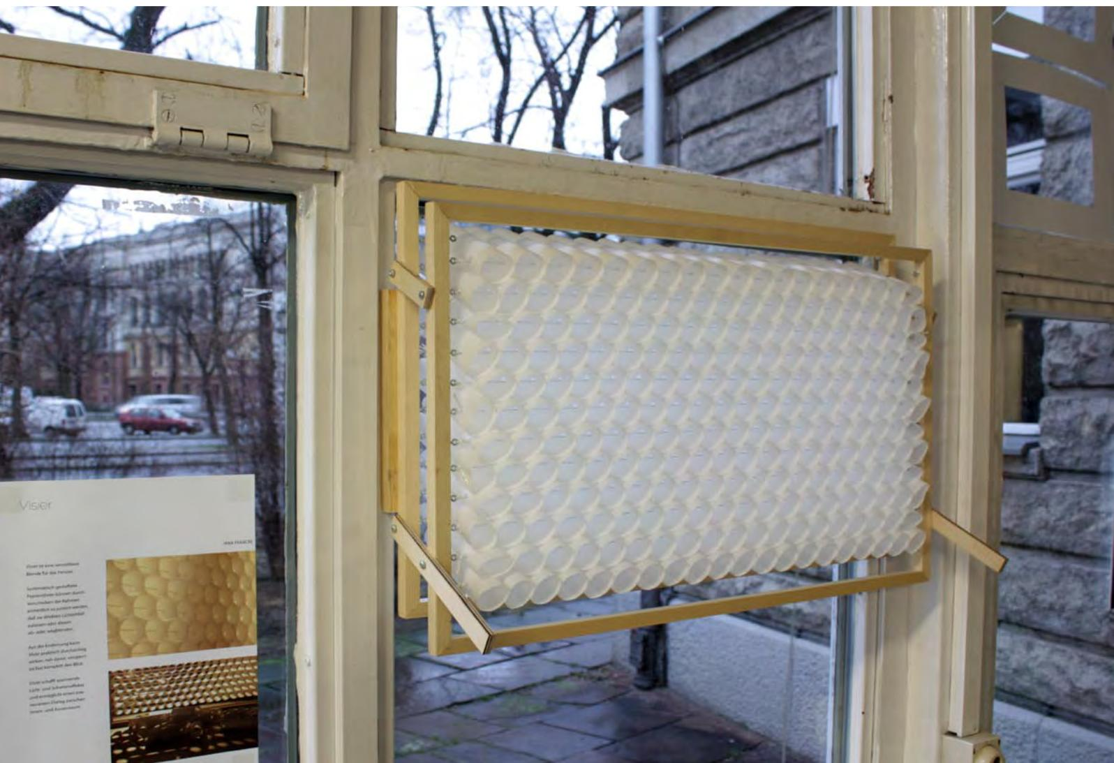
*Visier* ist eine verstellbare Blende für das Fenster. Systematisch gestaffelte Papierröhren können durch Verschieben der Rahmen einheitlich so justiert werden, daß sie direkten Lichteinfall zulassen oder diesen ab- oder wegblenden. Aus der Entfernung kann *Visier* praktisch durchsichtig wirken, nah davor, versperrt sie fast komplett den Blick. *Visier* schafft spannende Licht- und Schatteneffekte und ermöglicht einen interessanten Dialog zwischen Innen- und Aussenraum.
